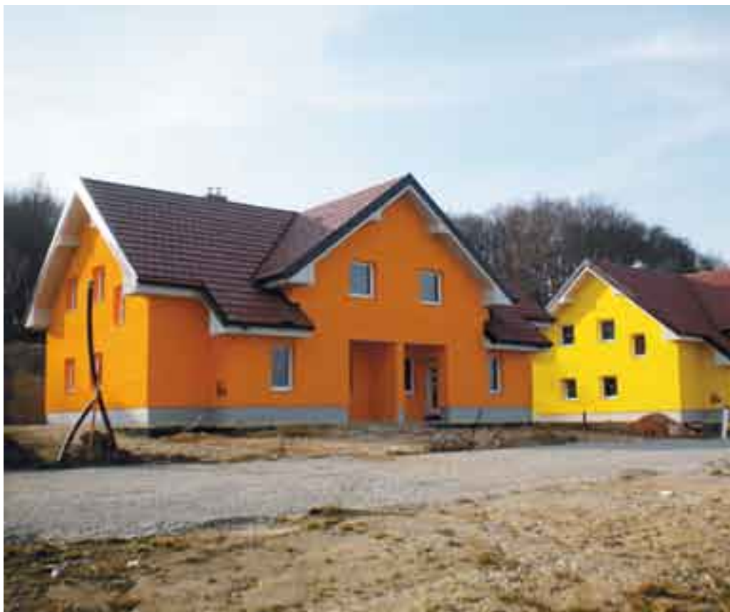
Dvojček v Jurovskem Dolu je zgrajen do četrte gradbene faze.
